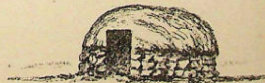
Fig. 8. Zakhpél (Kákar) Hut. Shór Valley. Chimján.
